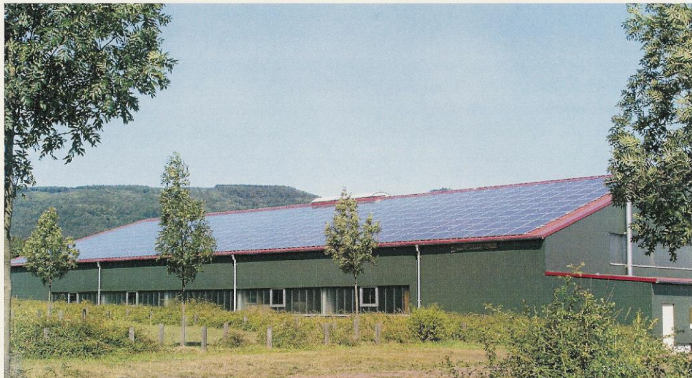
Photovoltaikanlage auf einer Fahrzeughalle in Meißner-Germerode, Leistung 59 Kilowatt
